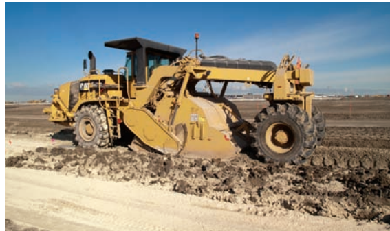
Стабилизация грунта улучшает технологические свойства грунта
